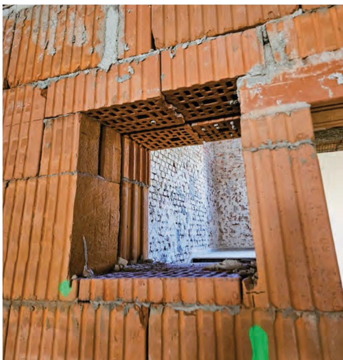
17 | ... oder einfach das Entfallenlassen eines Sturzes
