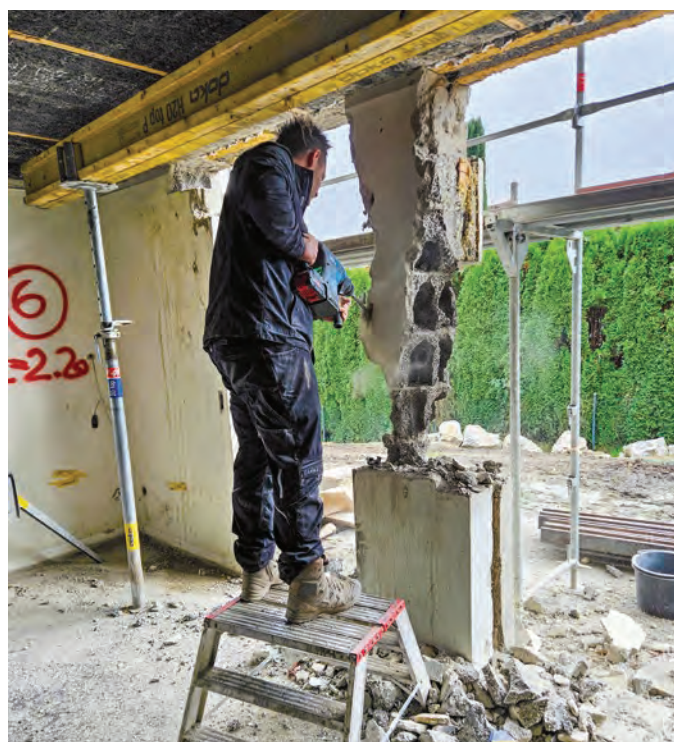
3 | Der Abbruch: eine Kunstform am Bau
