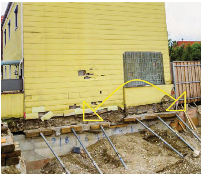
11, 12 | Hier kann sich im Bereich der Glasbausteine keine Scheibenwirkung und kein Gewölbe ausbilden ... dann sind Risse in Zentimeterbreite ggf. die Folge.
