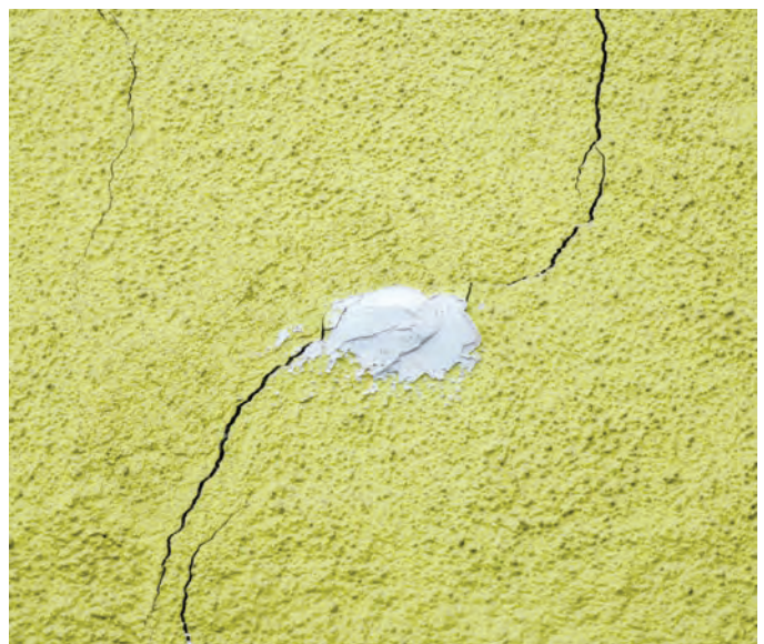
11, 12 | Hier kann sich im Bereich der Glasbausteine keine Scheibenwirkung und kein Gewölbe ausbilden ... dann sind Risse in Zentimeterbreite ggf. die Folge.
