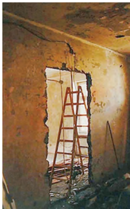
7, 8 | Überlasten einer einzelnen Wand durch vorschnellen Abbruch anderer Wände ... mit der Folge, dass diese Wand nun ausknickt
