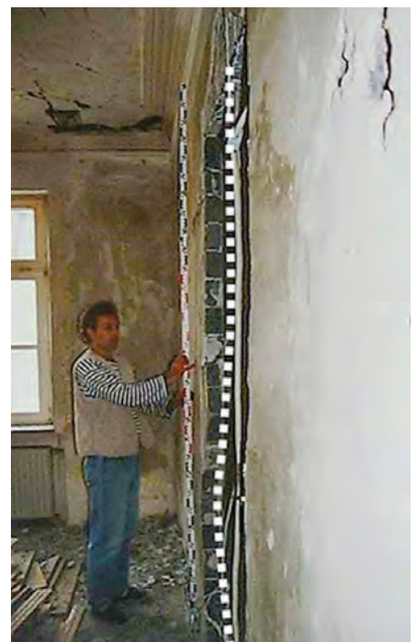
7, 8 | Überlasten einer einzelnen Wand durch vorschnellen Abbruch anderer Wände ... mit der Folge, dass diese Wand nun ausknickt
