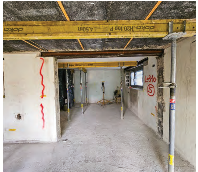
5 | Eingebauter kraftschlüssiger Ersatzträger, Hilfsjoche bereits um 2,0 m versetzt
