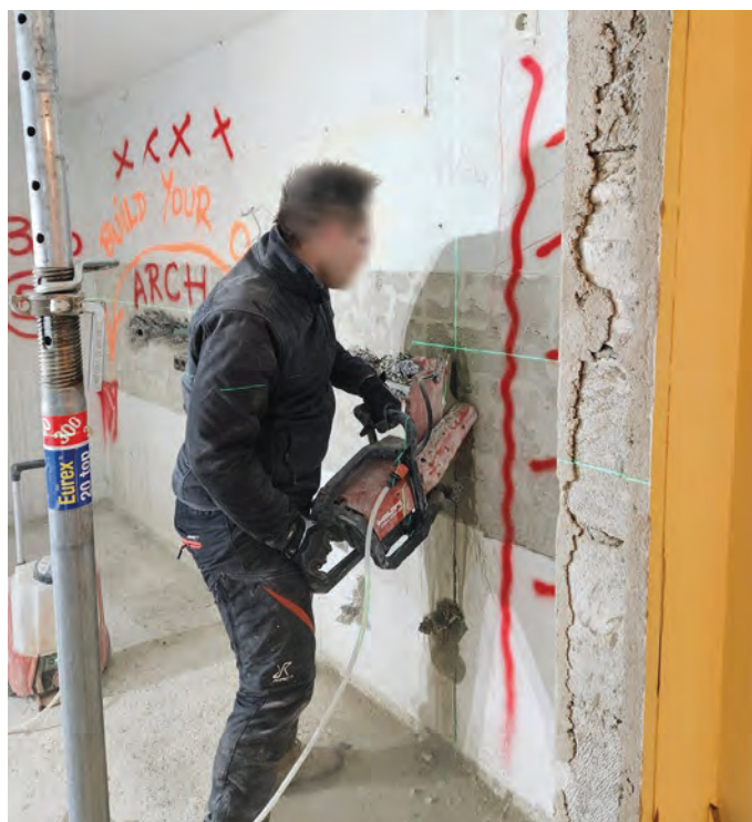
2 | Schonender Wandabbruch durch Mauersägeschnitte
